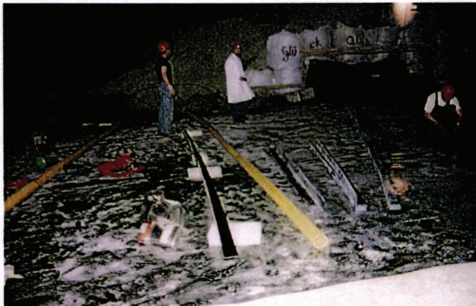
Abbildung 25: Verlegung der PE-HD Winkel und der Drainagerohre [10], ohne Datum
