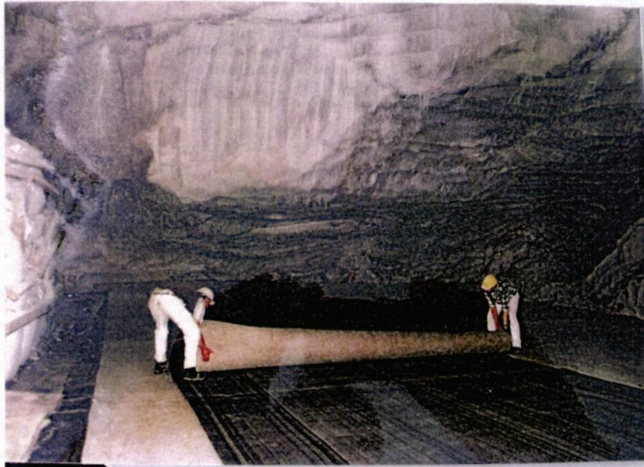
Abbildung 17: Einbau des PP-Vlieses [10], Aufnahme von 1997
