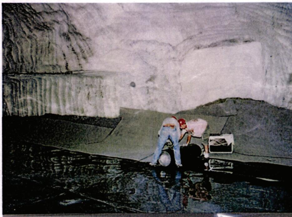
Abbildung 19: Verlegung der Kunststoffdichtungsbahn [10], Aufnahme von 1997
