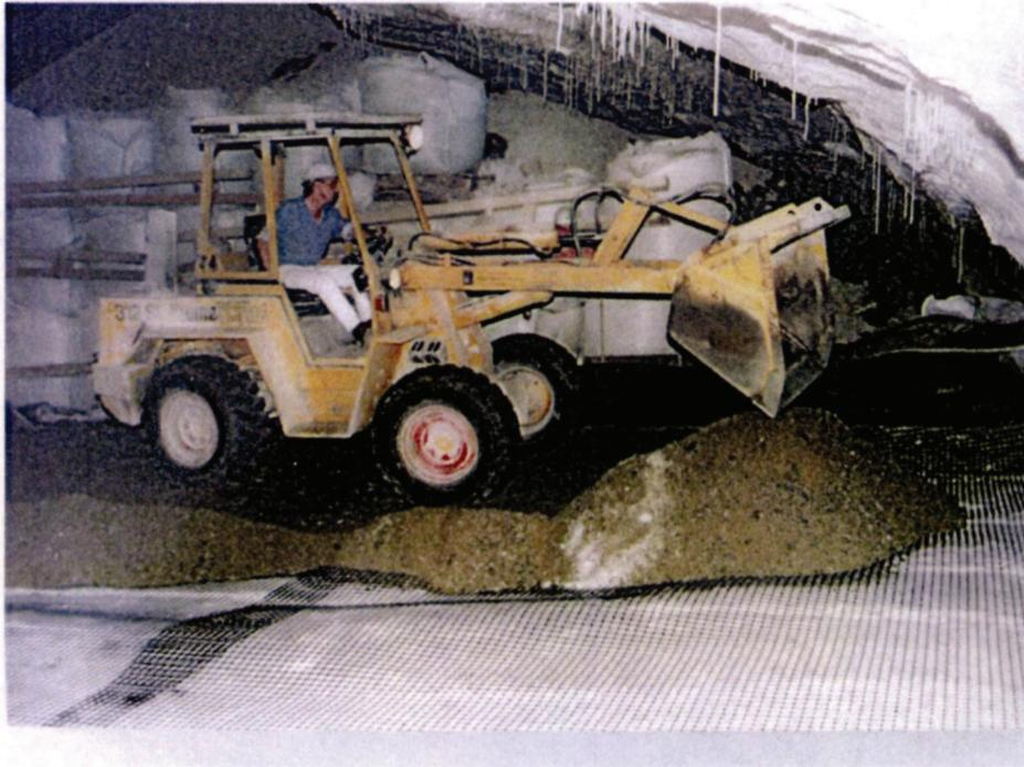
Abbildung 15: Einbau Ausgleichsschicht über verlegtem Traggitter [10], Aufnahme von 1997
