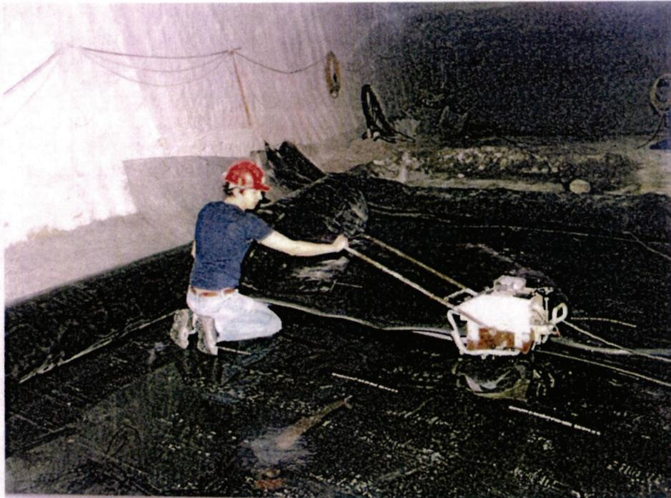
Abbildung 22: Schweißarbeiten an der Kunststoffdichtungsbahn [10], Aufnahme von 1997
