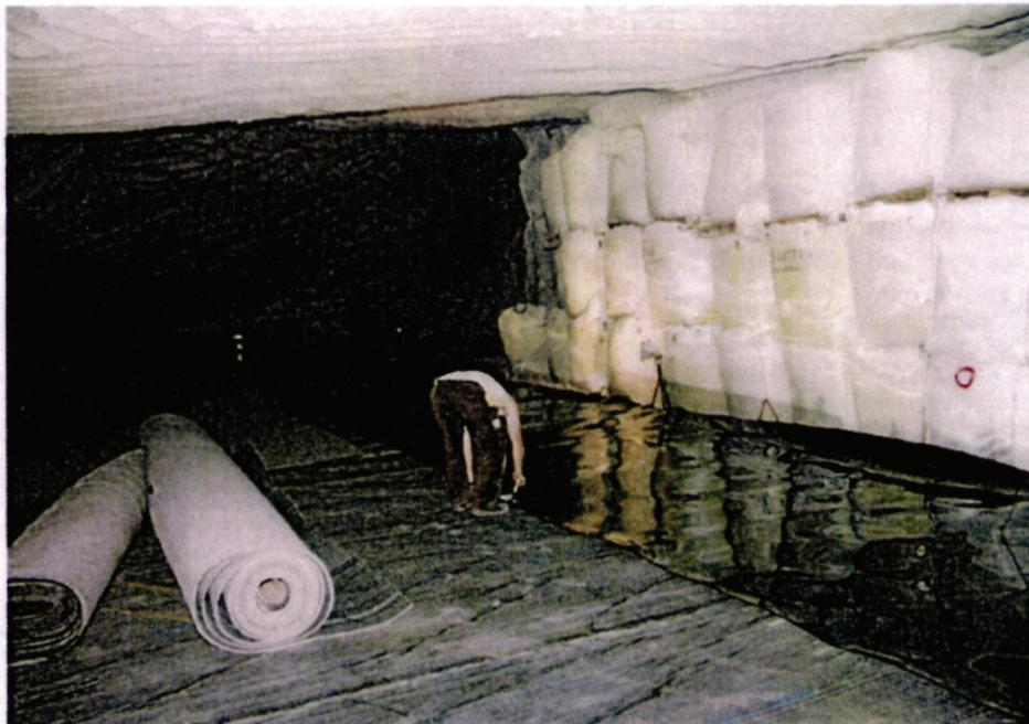
Abbildung 18: Verlegung der Kunststoffdichtungsbahn [10], Aufnahme von 1996
