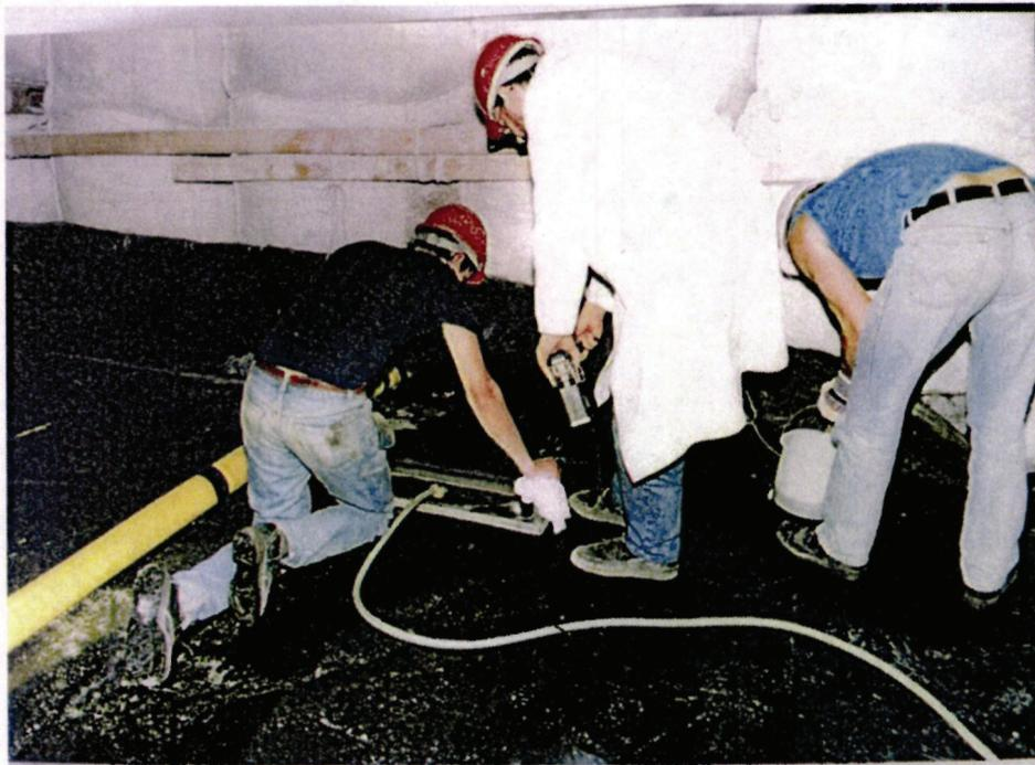
Abbildung 23: Druckluftprüfung der Schweißnähte [10], Aufnahme von 1996
